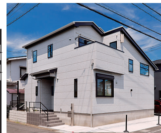
2階 コンクリート調の白い外壁が青空に美しく映える。窓枠や破風の黒色がアクセントに
