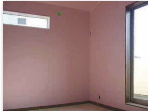
ハイクリンボードの施工(壁紙施工前)
