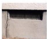
地震による換気口の断裂
