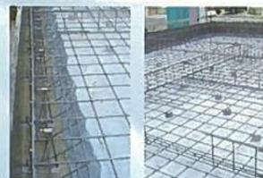
強固な基礎構造にするために、鉄筋の配筋にもこだわりました。基礎の立ち上がり部分の主筋には、直径13mmの異形鉄筋を採用。ベース部分(耐圧盤)は200mm間隔で直径13mmの鉄筋を格子状に配筋します。細かく配筋することで鉄筋量を増やし、より強固な基礎づくりを実現しました。
