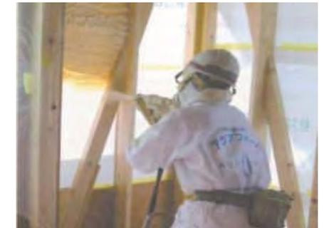
アクアフォームは、住宅の隅から隅まで家全体をすっぽり覆ってしまう現場吹き付け発砲による断熱工事です。透湿性も低く、断熱内部に湿気を侵入させないため、躯体内の結露を防止し、建物の耐久性を高めます。
