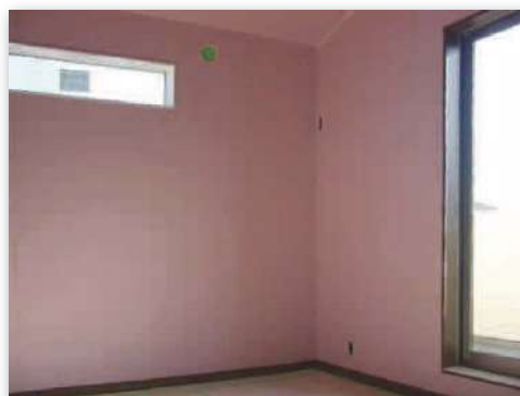
ハイクリンボードの施工(壁紙施工前)
