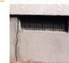
地震による換気口の断裂
