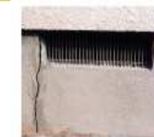
地震による換気口の断裂
