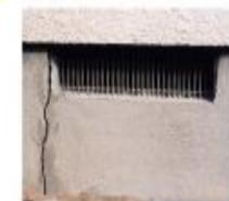
地震による換気口の断裂
