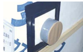
外壁貫通部の防水措置
