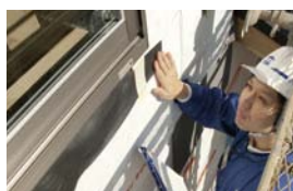
窓等の開口部の防水措置
