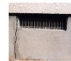
地震による換気口の断裂
